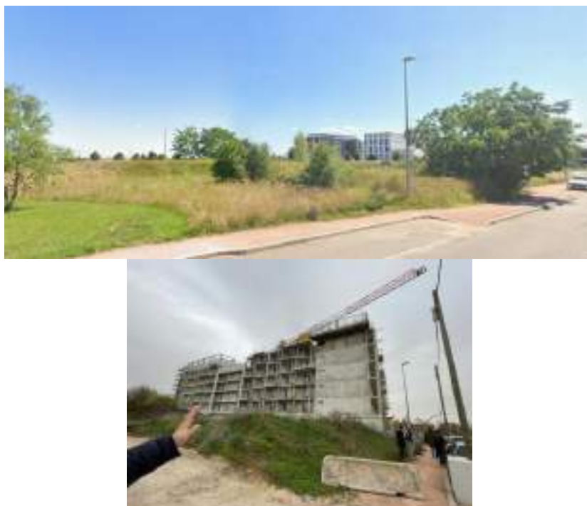
Figure 4: Gauche : terrain de la Ville de Dijon avant construction / A droite : en cours de construction (fin 2025)
